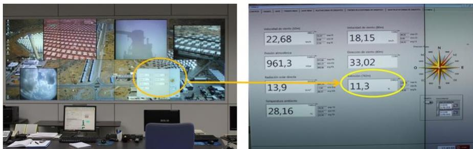
Fig.4. Extinción atmosférica monitorizada por primera vez en el panel de control de una planta solar de torre (CESA1, PSA)
